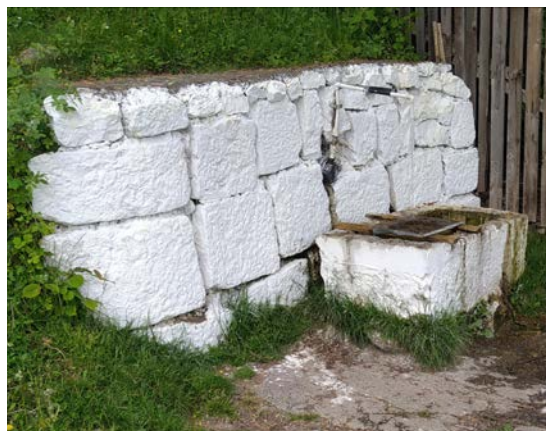
Fig. 7 Dragoslavele, fântână construită din piatră de talie. Pentru localizare vezi Fig. 6.
